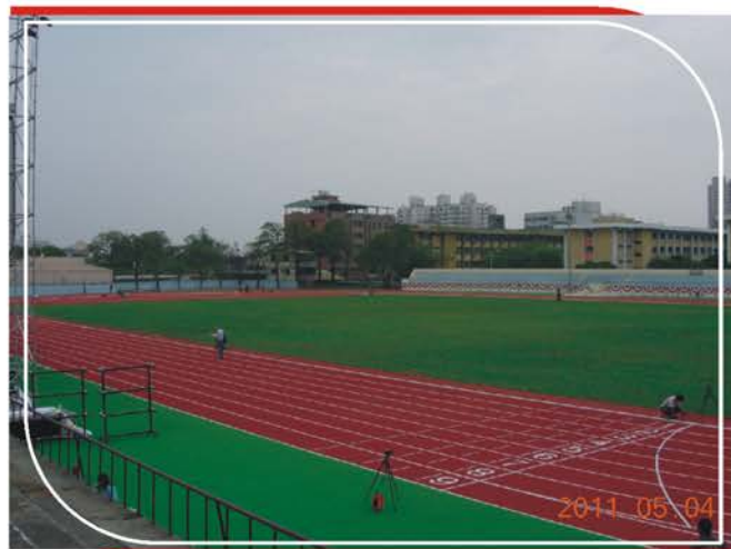
【田徑場施工後-1】
