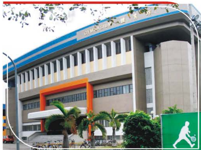
【體育館施工後】
