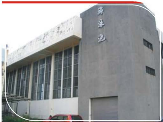
【游泳池施工前】
