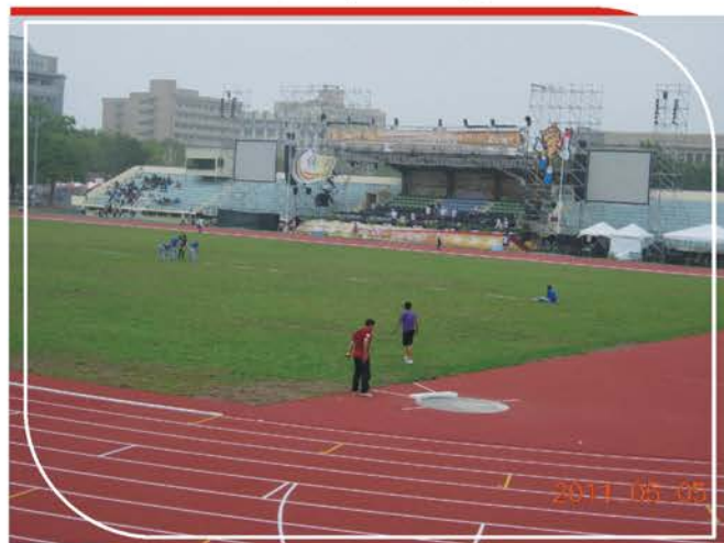
【田徑場施工後-2】
