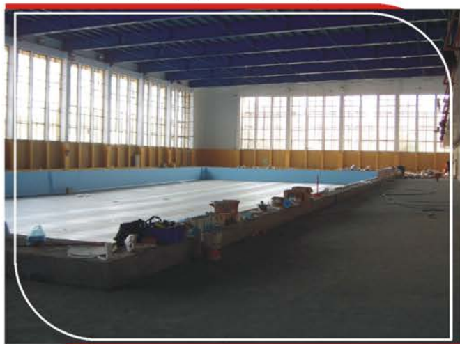
【游泳池施工前】
