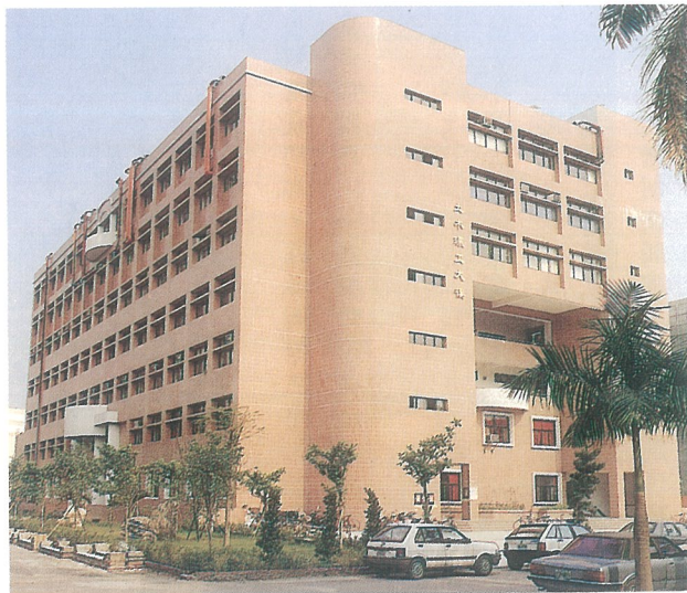
樓大工環木土
